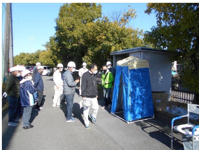
仮設トイレ設置
